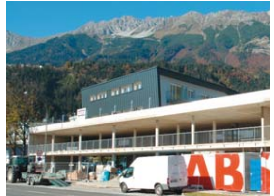
1 Wohn- und Büroanlage Weyrer-Areal, Innsbruck Foto pendlarchitects
