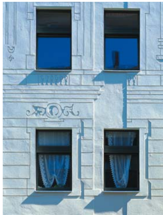
1 Fassadensanierung Belziger Straße, Berlin-Schöneberg Foto Michael Heinrich
