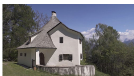
Welzenbacher_Settari_Schaller.jpg Lois Welzenbacher, Haus Settari, Bad Dreikirchen, 1922–23 Bildnachweis: © Lukas Schaller (Film-Still)
