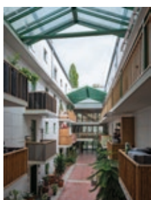
Hufnagl_Gerasdorfer_Feiersinger.jpg Wohnhausanlage Gerasdorfer Straße, Wien-Floridsdorf Bildnachweis: © Werner Feiersinger
