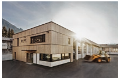
Bau- und Recyclinghof, Absam Architektur: DIN A4 Architektur, Innsbruck Foto: Andre Schönherr
