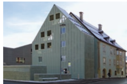
Dengelhaus, Sanierung und Erweiterung, Reutte Architektur: Alois Ortner, Ursula Ortner-Mahuschek, Innsbruck Foto: Alois Ortner
