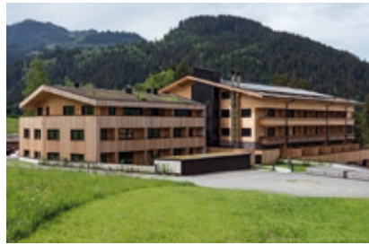
Alpenhotel Kitzbühel, Kitzbühel Architektur: FIRN Architekten, Kitzbühel Foto: FIRN Architekten
