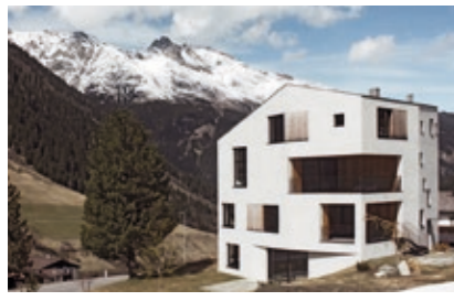
Apartmentgebäude Juifenau, Gries im Sellrain Architektur: Michael Lukasser, Innsbruck Foto: Veronika Acher
