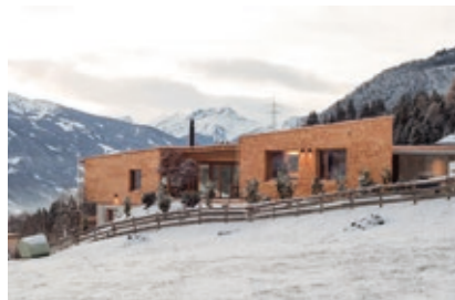
Haus Plattner, Fügenberg Architektur: architekturWERKSTATT, Breitenbach Foto: Bruno Moser
