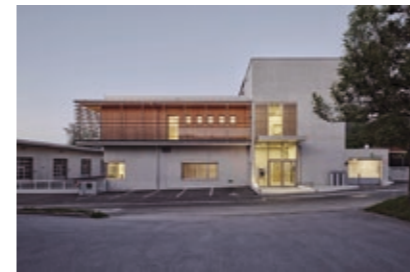
Gebietsbauleitung der Wildbach- und Lawenverbauung Unteres Inntal, Wörgl Architektur: Erwin Frick, Silz Foto: David Schreyer
