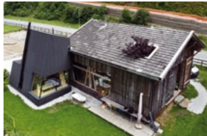
Haus Moser, Zubau, Neustift im Stubaital Architektur: Madritsch/Pfurtscheller (Robert Pfurtscheller), Innsbruck Foto: Daniel Pfurtscheller
