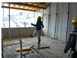
Baustelle_kids.jpg Baustelle „Q-West“ – Baustellenbegehung mit SchülerInnen im Rahmen von p[ART] - Partnerschaften zwischen Schulen und Kultureinrichtungen Bildnachweis: © aut
