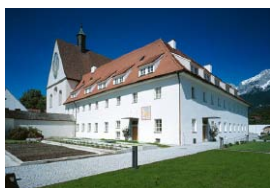
4_Telfs_Wett.jpg Franziskanerkloster Telfs; Revitalisierung: Architekturhalle Wulz-König Foto: © Günter Richard Wett
