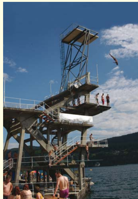
Sprungturm Millstättersee, errichtet 1930 Die 10 Meter hohe Betonkonstruktion wurde anlässlich eines Turmsprung-Events 2007 mit einer Stahlkonstruktion auf 22,5 Meter erhöht, später stellte man wieder den Originalzustand her. Foto: Peter Nigst
