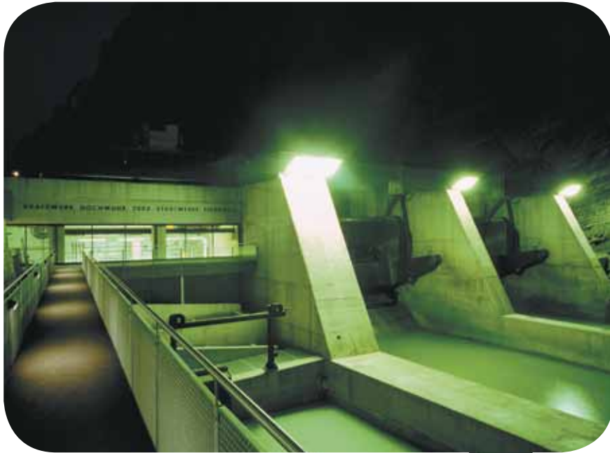
Hydrokraftwerk Hochwuh, 2004, Artec Architekten, Foto: marclins.com
